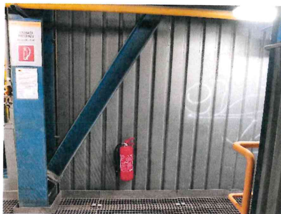
Pravá strana obratovej komory K2
