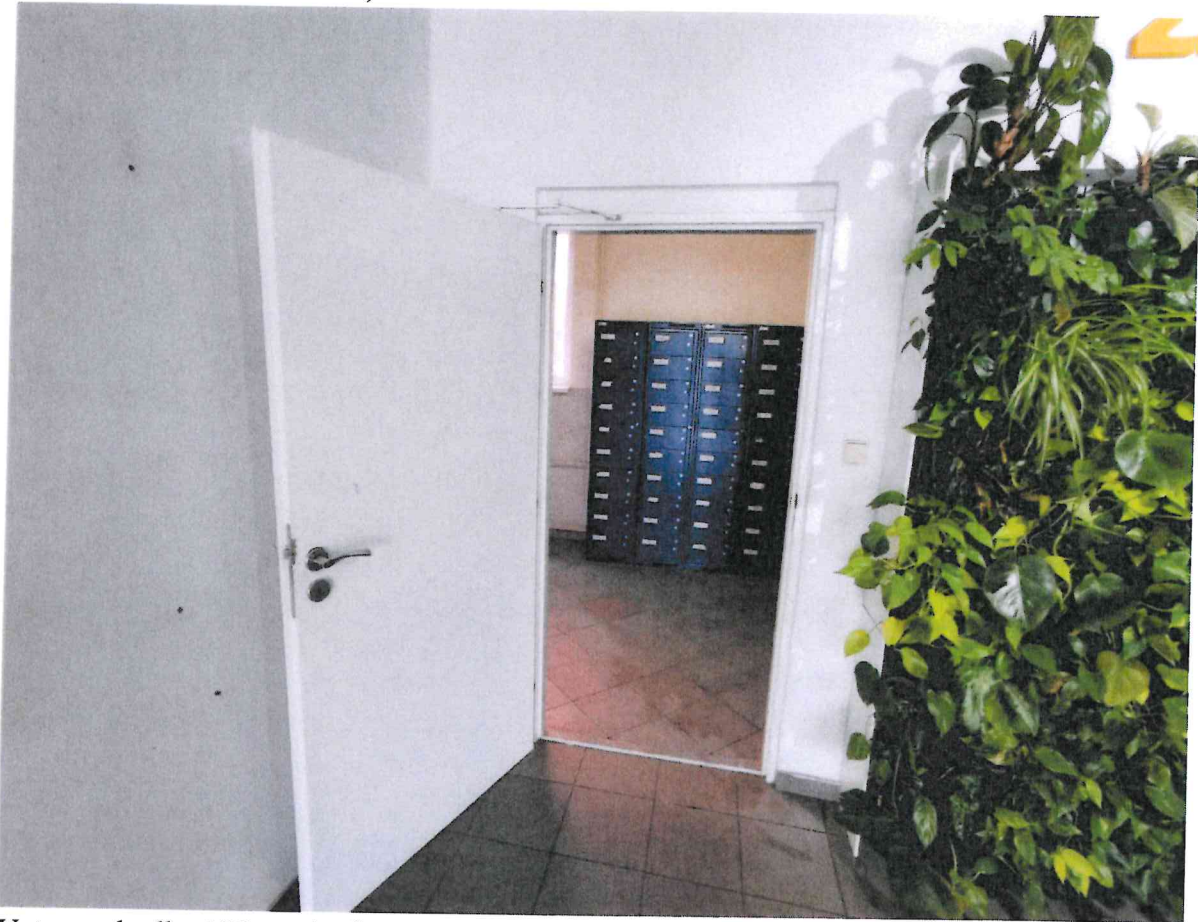
Vstup z chodby 102 na chodbu 135
