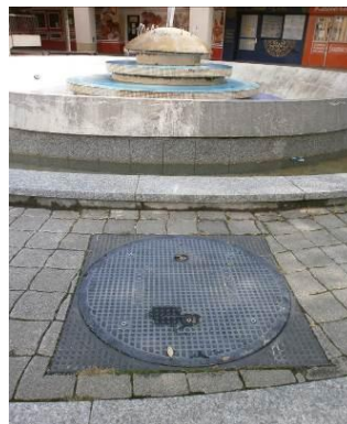
Fontána Šváby - technologickej šachty
