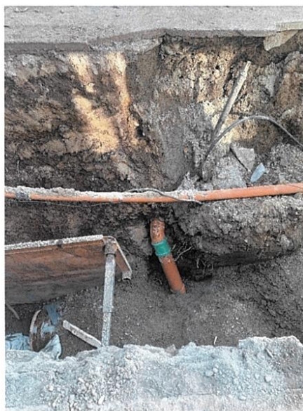
Hľadanie bodu napojenia na exist. vodovod DN100 podľa vytyčenia VVS a.s.:
