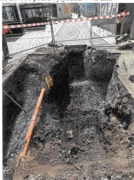
Hľadanie bodu napojenia na exist. vodovod DN100 podľa vytyčenia VVS a.s.:
