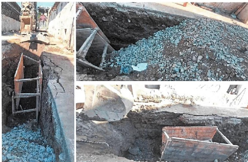
Obr. 1 Vľavo – uvoľňovanie steny výkopu, Hore – zásyp štrkodrvou, Dole – základová pôda - navážka
