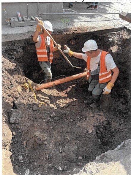
Hľadanie bodu napojenia na exist. vodovod DN100 podľa vytyčenia VVS a.s.:
