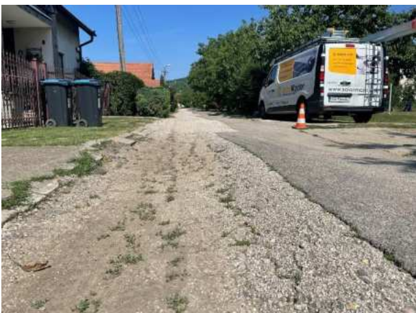
Preličená časť vozovky- severná strana
