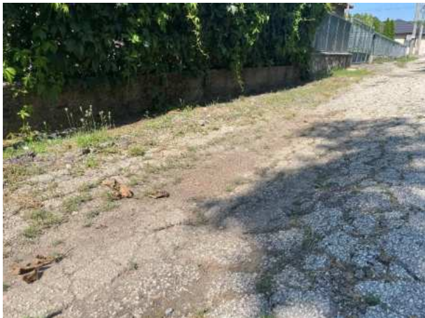
Vozovka nemá kraj, pokračuje do zelene
