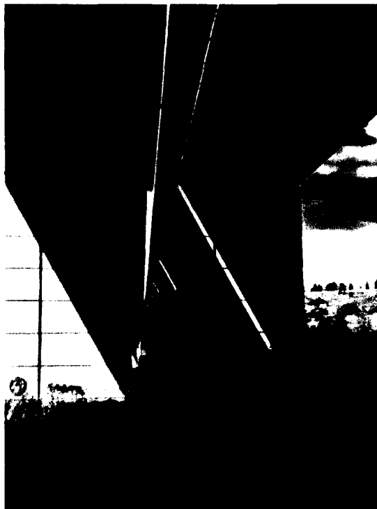
Obr. 2 Pohľad pod most
