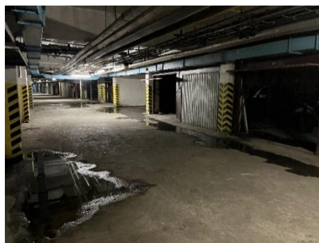
Obrázok č. 5.6 – fotografie porúch v objekte z hľadiska vlhkosti
