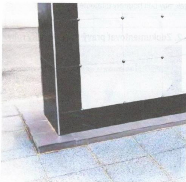
Ukážka prekrytia základov nalepením obkladu z dôvodu nerovností pri betonáži.
