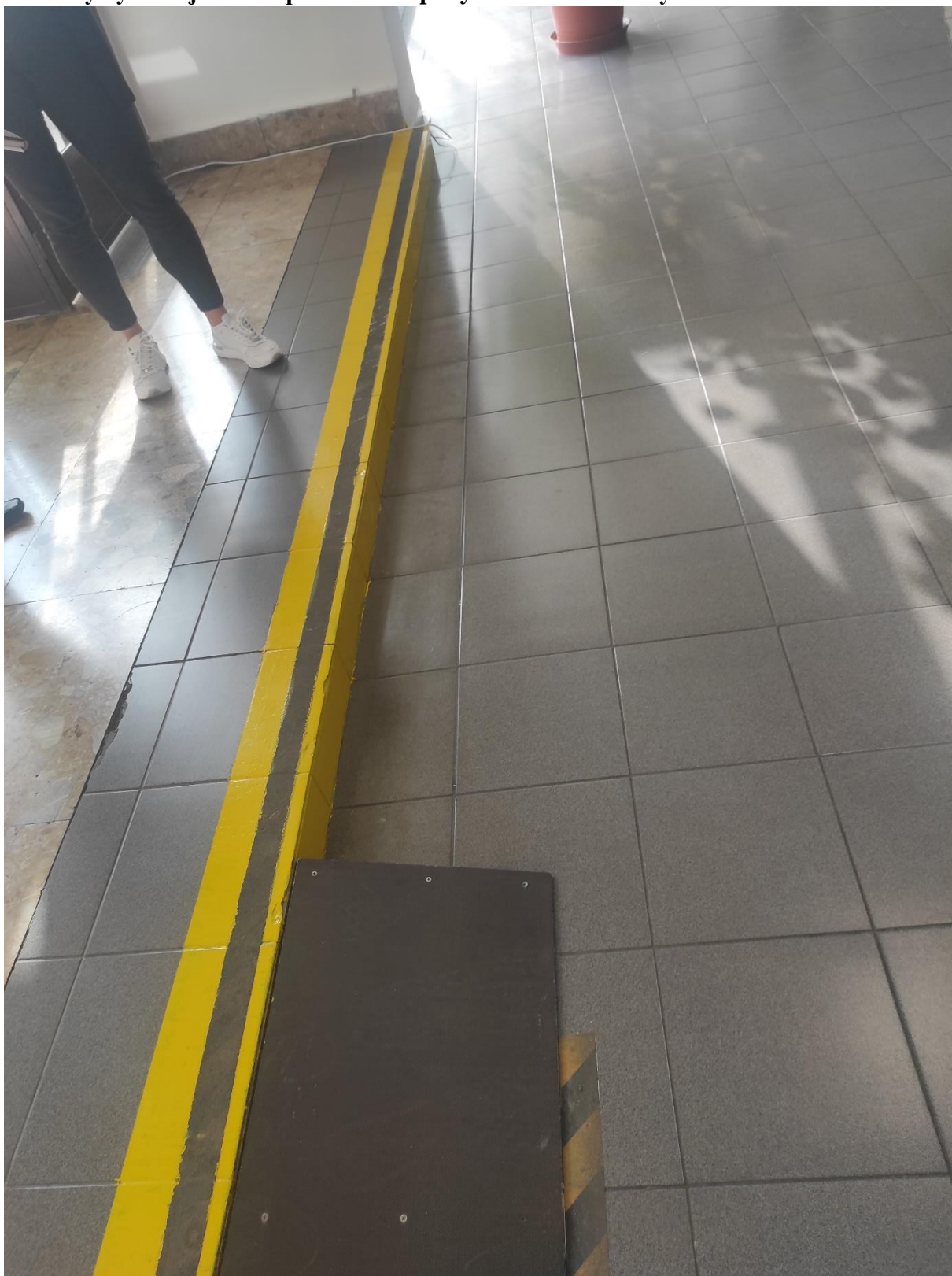
Prechod z vestibulu do jedálne – bariéra 1 schod
