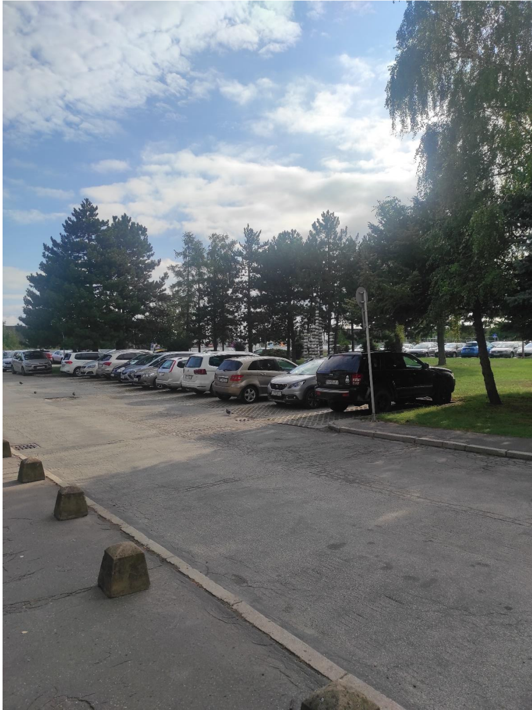
Miesto pre vyhradené parkovanie a bariéra - obrubník pri vstupe do budovy
