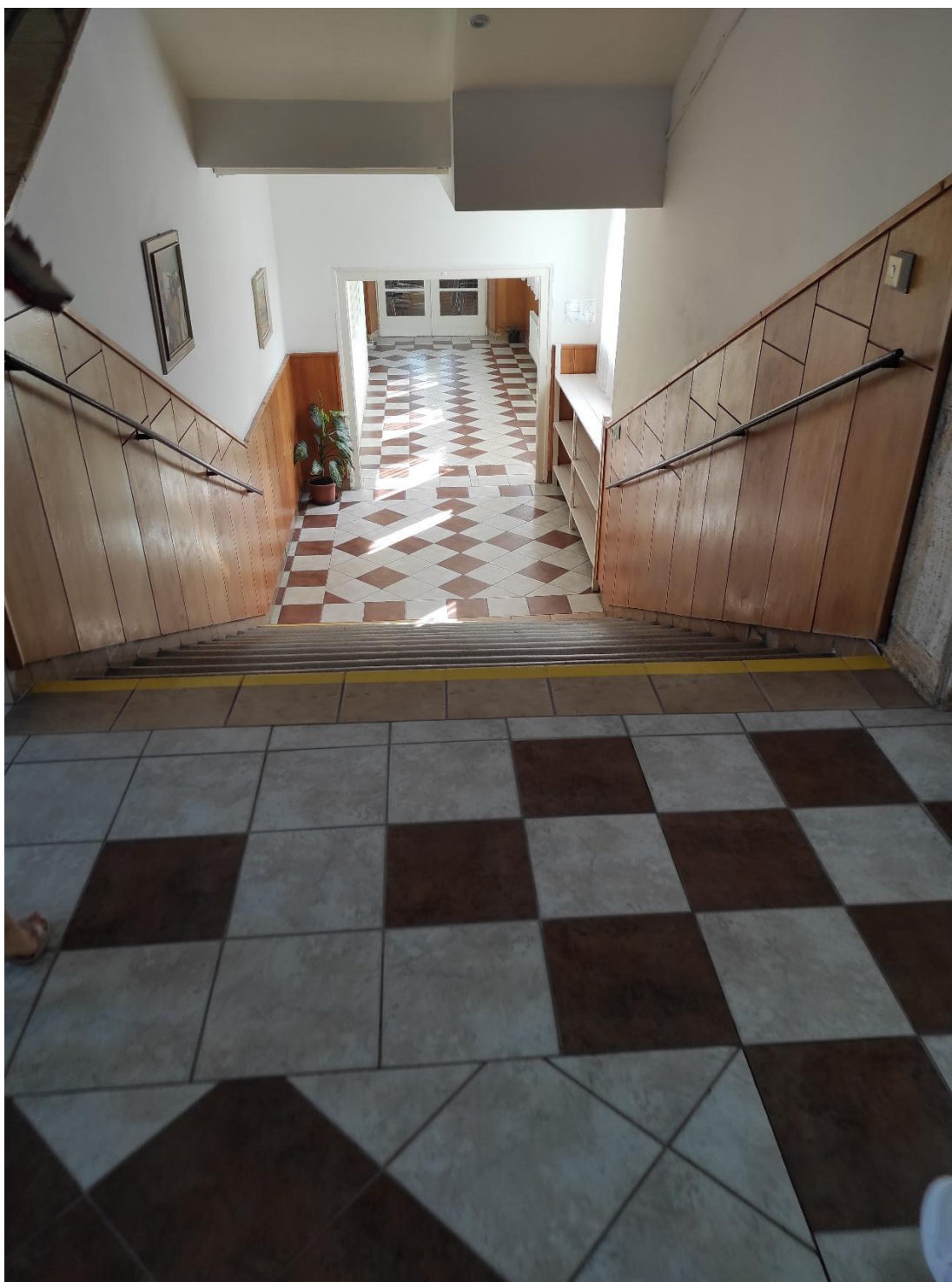
Schodisko do jedálne – schodisková plošina
