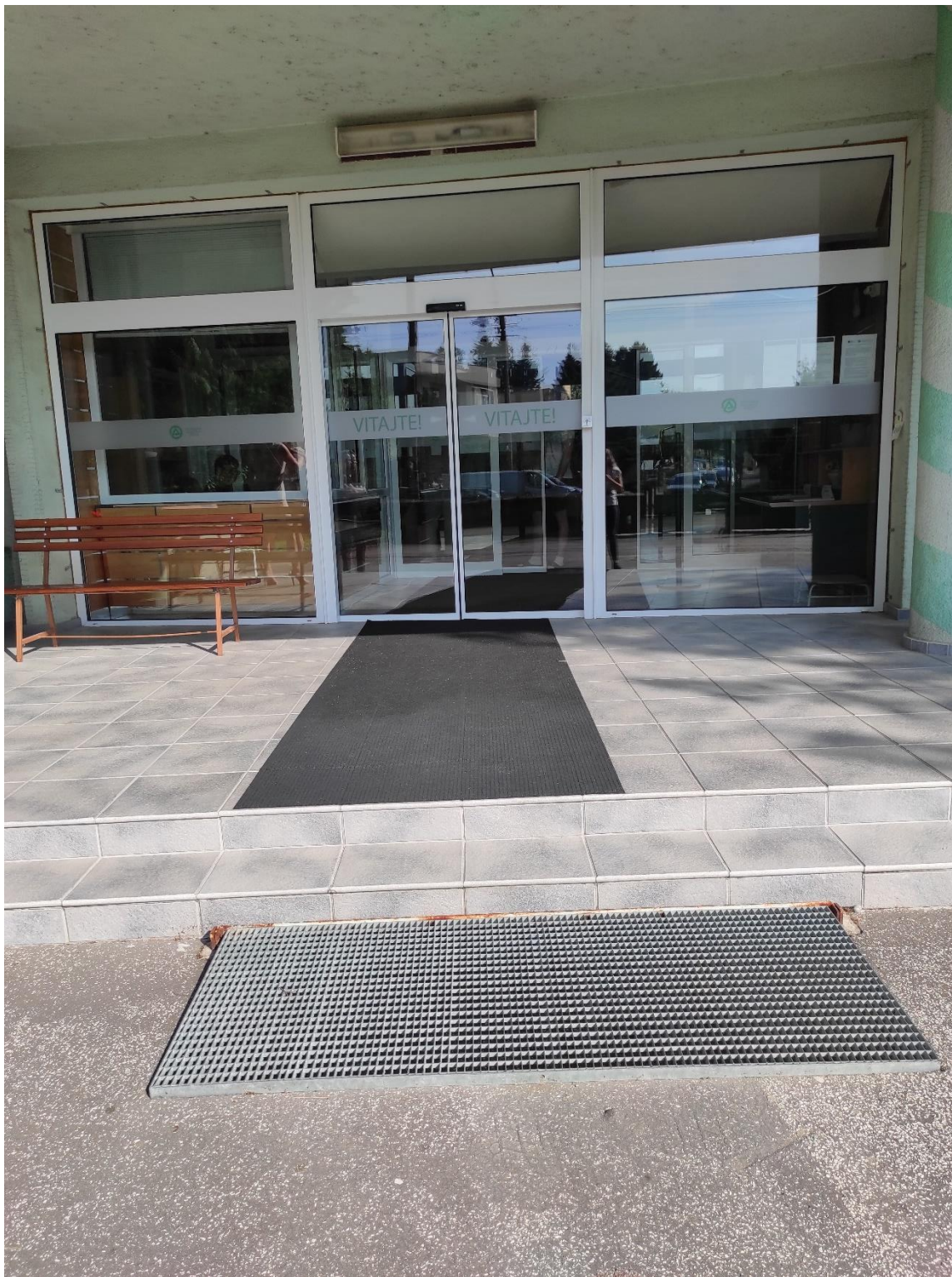
Hlavný vstup do budovy školy – navrhované miesto pre rampu
