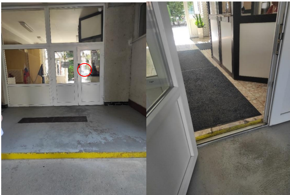
Vstupné dvere do budovy školy so zvončekovým/komunikačným panelom (v krúžku) a výškový rozdiel plôch
