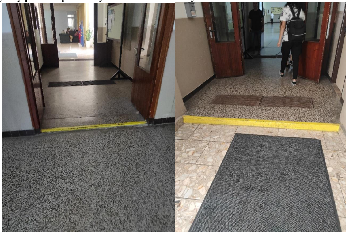
Výškový rozdiel plôch na prízemí budovy
