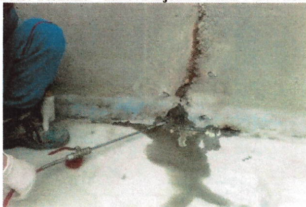
Foto: Tesnenie – tlaková injektáž trhlín v Ž.B. konštrukcii – polyuretanové tesniaca živica:
