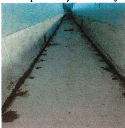
Foto: Aplikácia hydroizolačnej stierky
