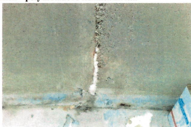
Foto: Tesnenie – tlaková injektáž trhlín v Ž.B. konštrukcii – polyuretanové tesniaca živica:
