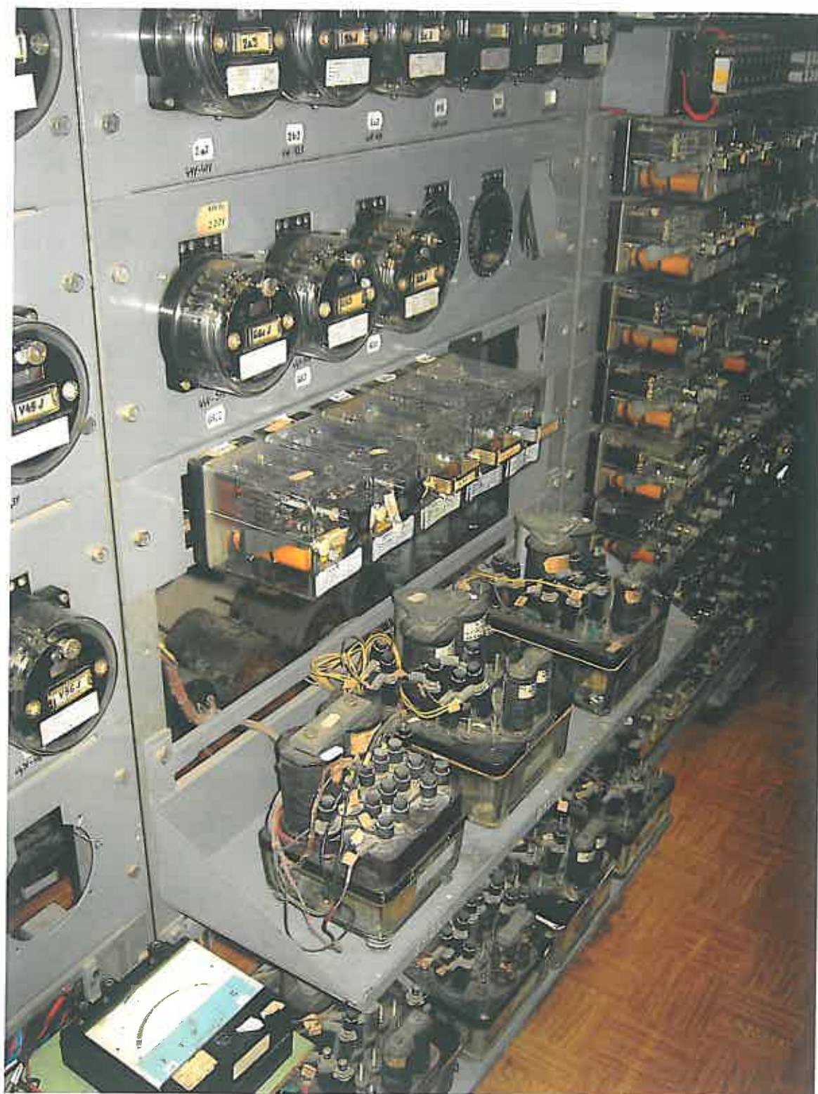
Príloha č.7d koľajové prijímače WSSB v ŽST Margecany
