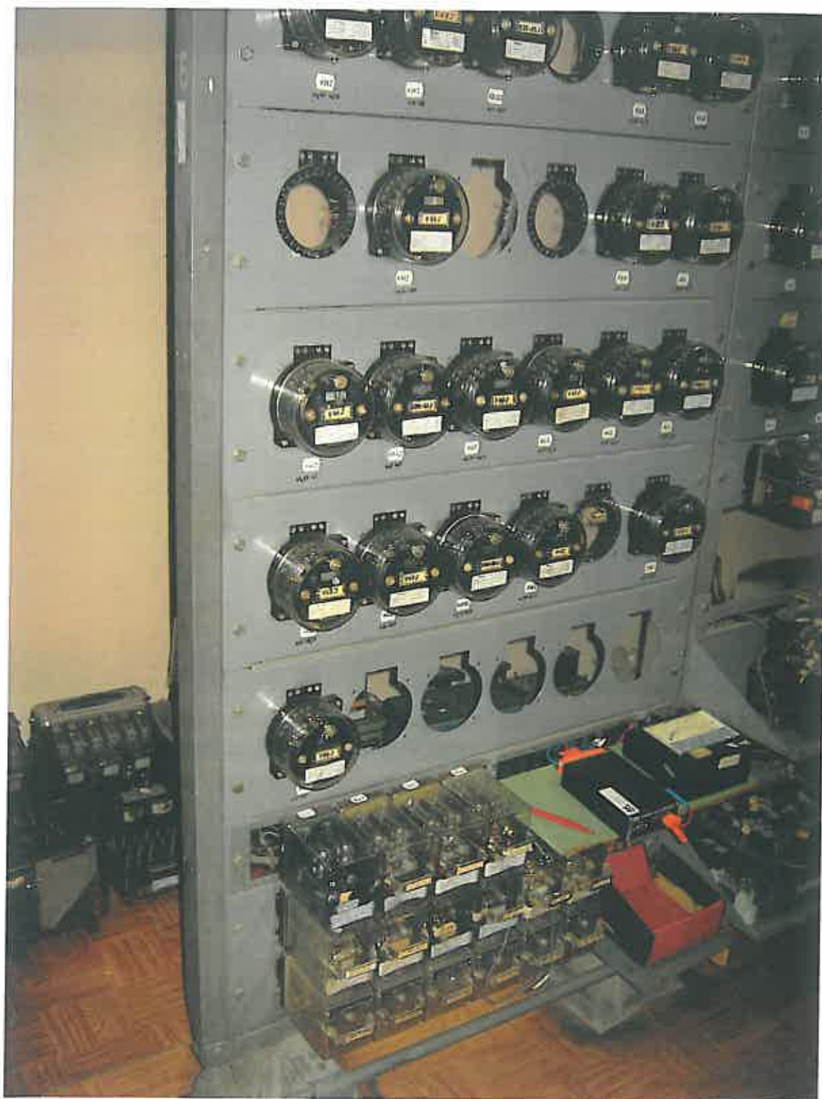
Príloha č.7b koľajové prijímače WSSB v ŽST Margecany
