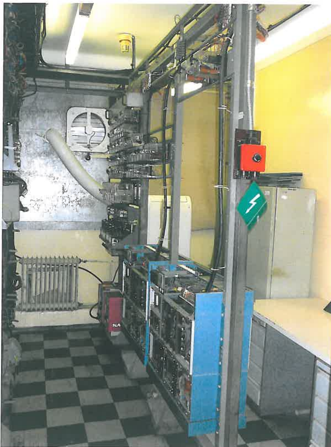
Príloha č.5b meniče BZB 1-275 a voľné stojanové rady v NŽST Kostofany nad Hornádom
