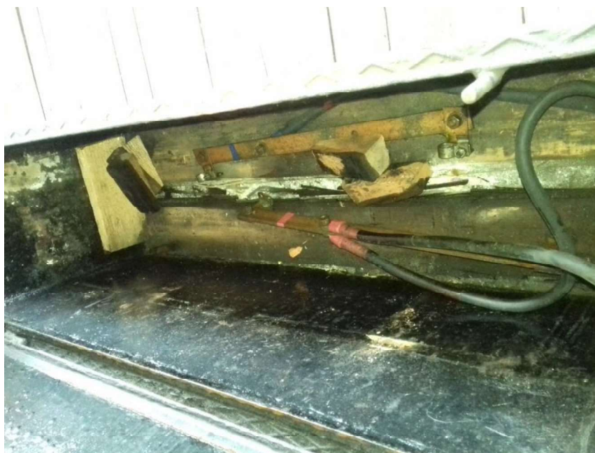
Miesto pre uloženie akumulátorových batérii
