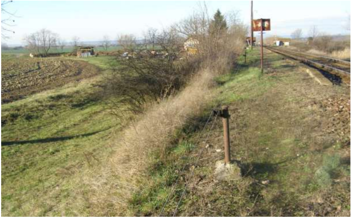
Zast. Holiša- násyp a nástupište
