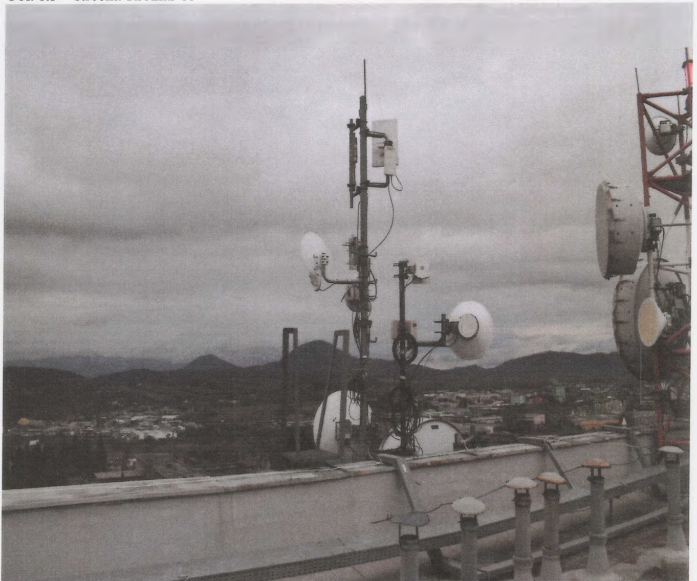
Obr. č.3 – strecha-strožiar S3
