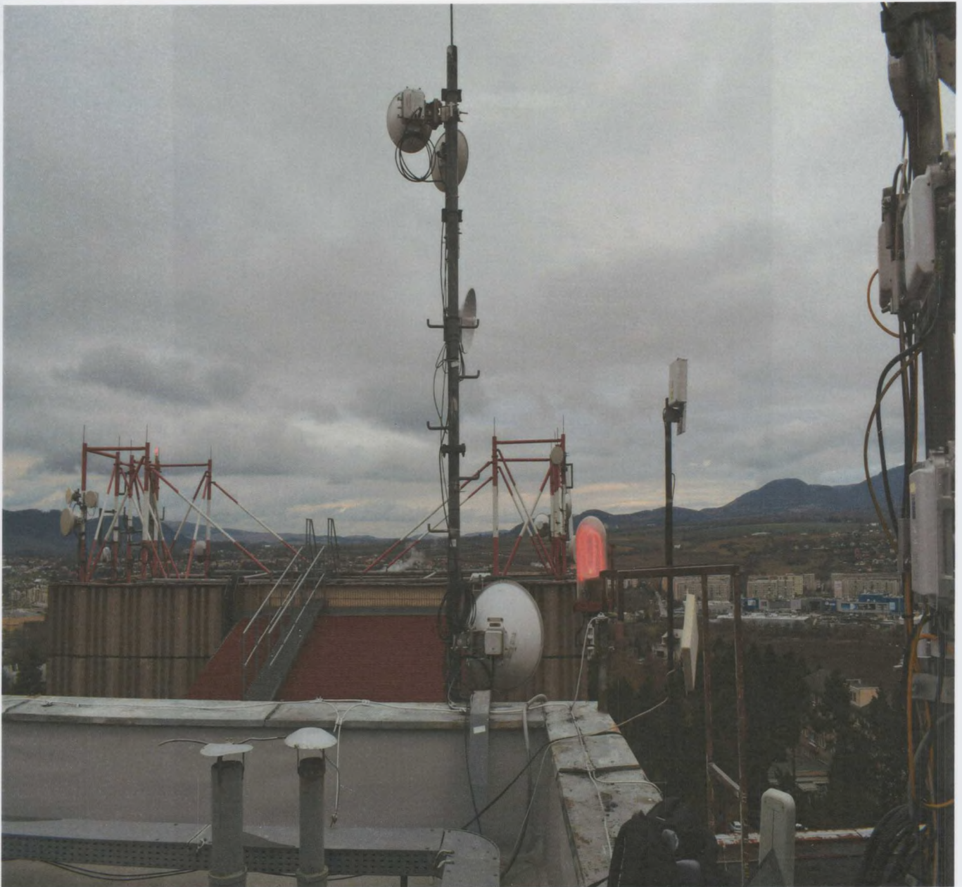
Obr. č.4 – strecha-strožiar S4
