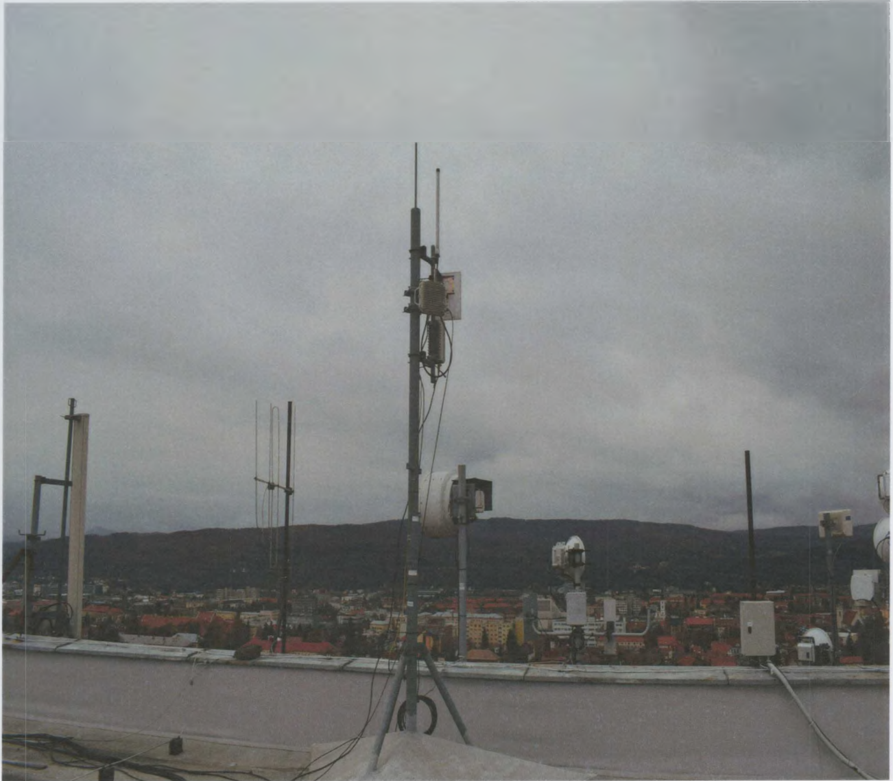
Obr. č.2 – strecha-strožiar S2
