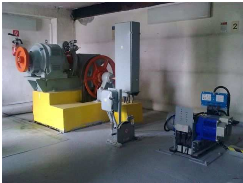
Pôvodný stroj a nový stroj rady GeN2 ReGen na dvoch zhodných výťahoch
