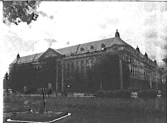
Pohľad severo východný
